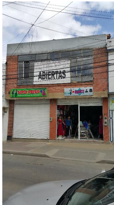
Fachada sobre Tv. 92 Bis
